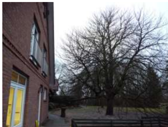
Abb. 15 Blick von Süden entlang der östlichen Seite des Klinikgebäudes auf die ortsbildprägende Kastanie innerhalb einer Gartenfläche (R. Pollok 20.01.2012)
