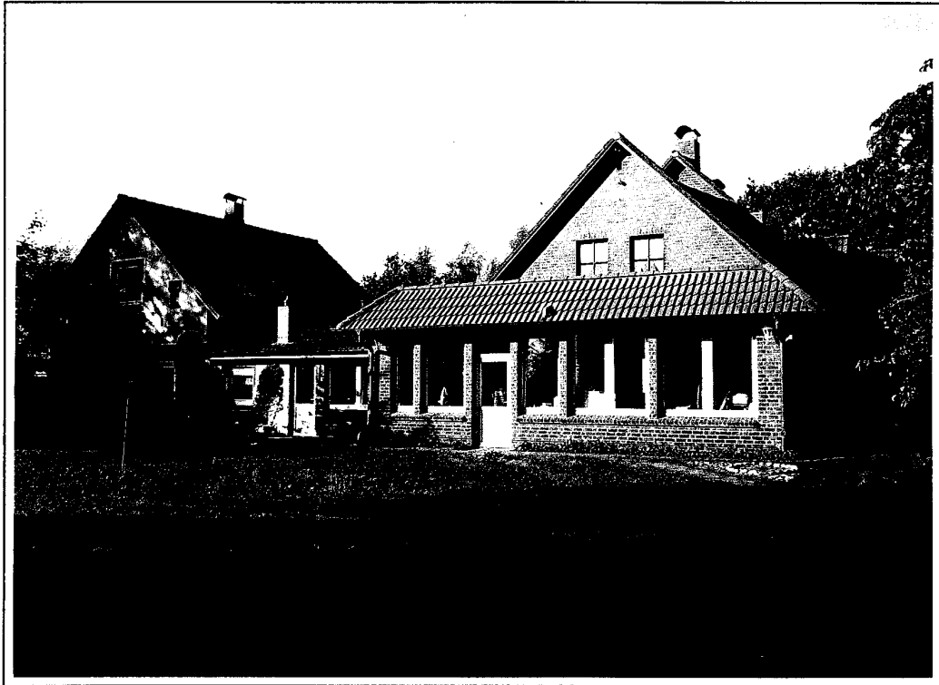
Abb. 7: Blick von Süden auf die rückwärtige Gebäudeseite der heutigen Praxis mit dem westlich anschließenden (ehemaligen) Altenteiler und dem Wohnhaus im Hintergrund, im September 2001
