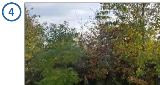
Solarpark nicht einsehbar
