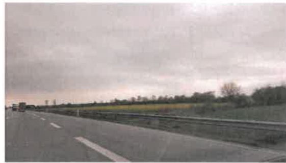
Abbildung 11: Fahrtrichtung Süden, Blick nach Südwesten: Blick in die Tiefe, paralleler Knick in 150 – 200 m Entfernung
