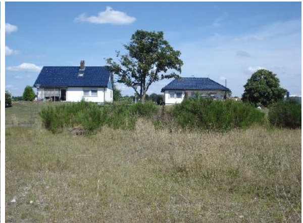
Abb. 20 ehem. „Musterhäuser“ nordöstlich des Plangeltungsbereichs mit baulichem Bestandsschutz (P. Scharlibbe 13.08.2010)
