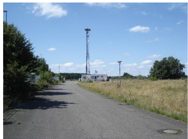
Abb. 21 Blick von der privaten Erschließungsstraße aus auf den Mobilfunkmast am Wendeplatz der Industriestraße (P. Scharlibbe 13.08.2010)
