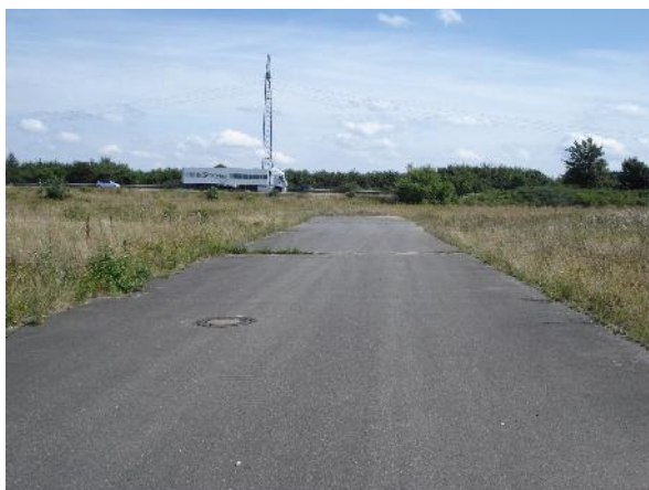
Abb. 28 Die private Erschließungsstraße im Zufahrtbereich der „Industriestraße“ (oben) und am heutigen Ende nahe der BAB A7 (unten) (P. Scharlibbe 13.08.2010)
