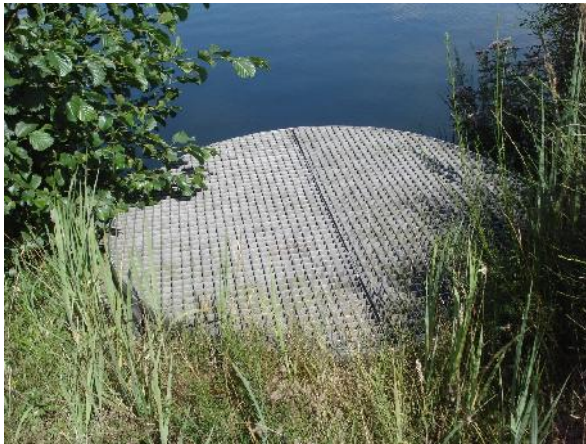
Abb. 31 Wasserentnahmestelle für die Feuerwehr am Ufer des „Trelleborgsees“ (P. Scharlibbe 13.08.2010)
