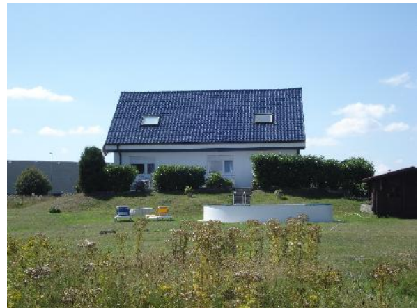
Abb. 19 Blick vom Seeufer aus auf das dem Büro- und Geschäftsgebäude zugeordnete Betriebsleiterwohnhaus (P. Scharlibbe 13.08.2010)
