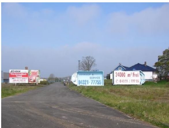
Abb. 20 Blick vom Ende der privaten Erschließungsstraße auf Werbeanlagen außerhalb der anbaufreien Strecke mit Ausrichtung zur BAB (R. Pollok 28.04.2010)
